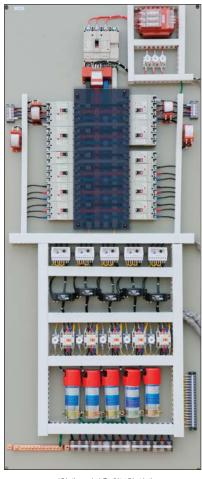
외함에 조립판을 취부한 상태 Assembly board set on cubicle
